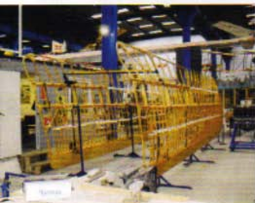
Die rechten Tragflächen der F.F. 49c, die so aussehen wird wie die T-DABA, die erste bei der Fluggesellschaft D.D.L. eingesetzten Maschine dieses Typs
